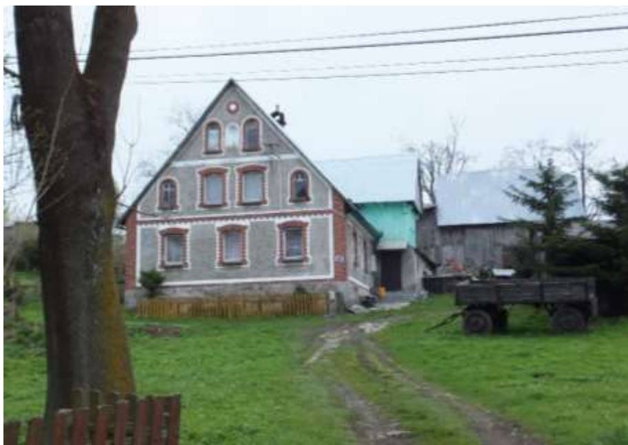
Ryc. 66. Przykłady tradycyjnej zabudowy sudeckiej z Gór Stołowych. Fot.: A. Latocha.
