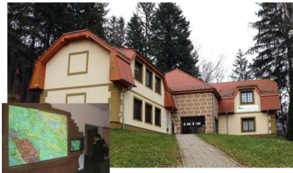
Ryc. 5. Ekocentrum w Kudowie-Zdroju. Fot.: E. Kurowska.
