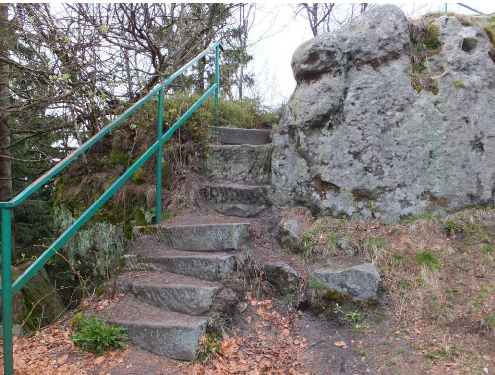
il.12.6. Po dawnym Forcie Karola pozostały m.in. kamienne stopnie częściowo wykute w skale, a częściowo ułożone z ociosanych piaskowcowych bloków.
