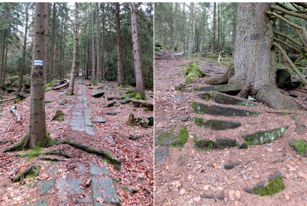
il.7.11. Korzenie drzew oraz różnorodne procesy stokowe (splukiwanie, spętywanie, akumulacja) prowadzą do stopniowego zacierania czytelności pochylni i schodów; Skały Puchacza.
