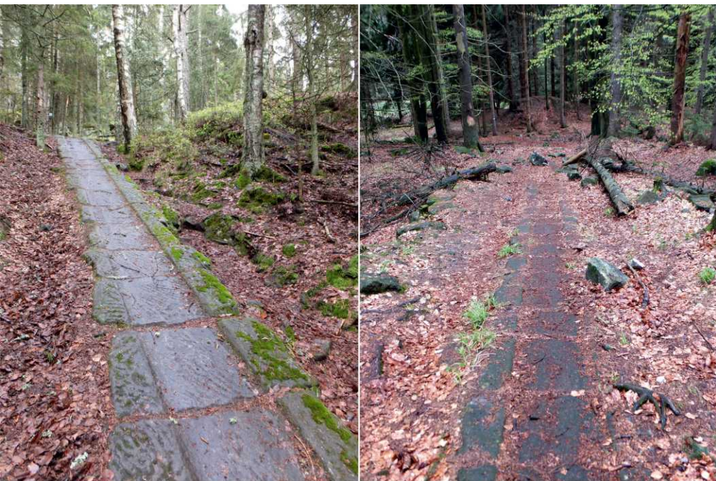
il.7.9. Kamienna pochylnia do transportu bloków z położonego powyżej kamieniołomu w Skatach Puchacza. U podnóża stoku widoczna ziemna rampa.
