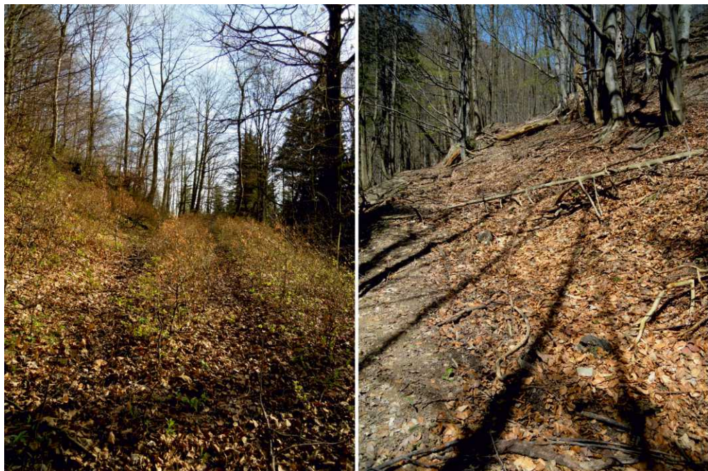
il.1.2. Zarastanie oraz osypywanie i spływanie materiału ze skarp prowadzą do stopniowego zacierania czytelności nieużytkowanych dróg.
