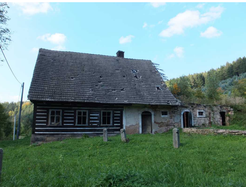
il.3.7. Opuszczony budynek w Pstrążnej z wyraźnym podziałem na drewnianą część mieszkalną i murowaną gospodarczą.
