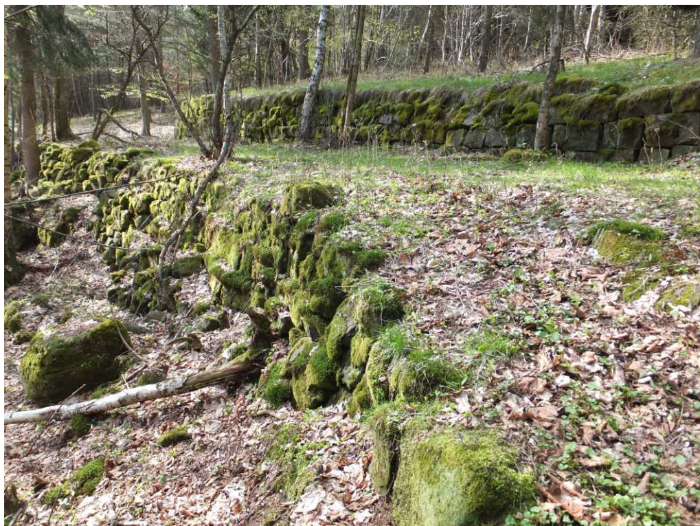
il.4.19. Kamienne umocnienia skarp drogowych i teras osadniczych w centralnej części wyludnionej osady Góra Anny.
