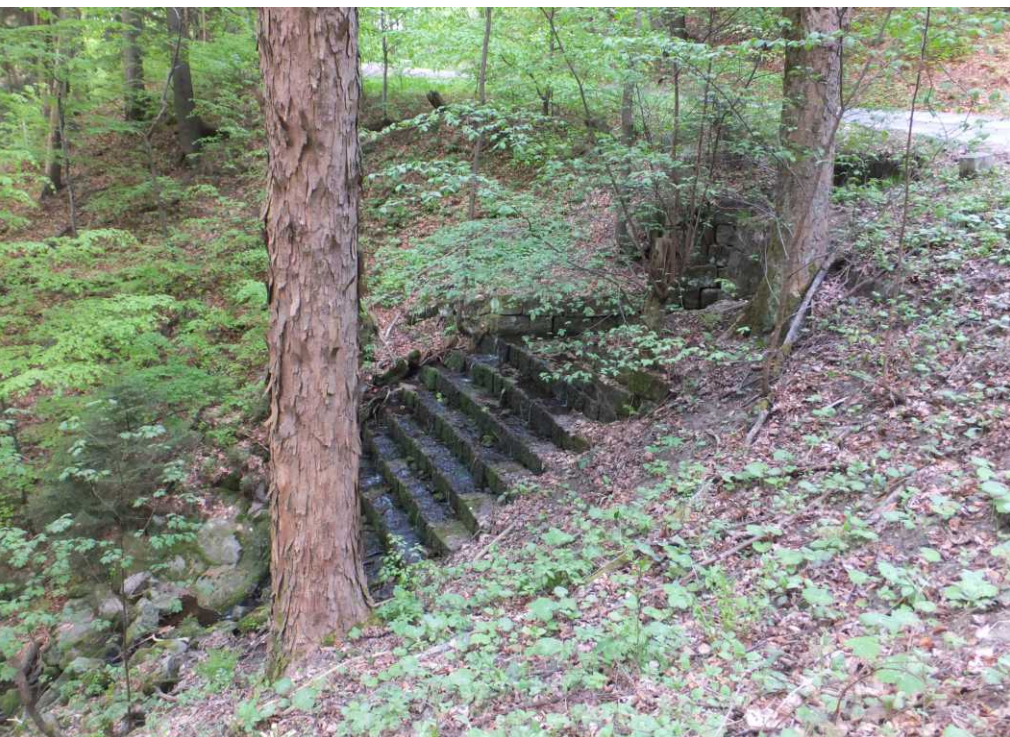
il.6.5. Imponujących rozmiarów przepust drogowy pod Machovską Drogą (potok Židovka) wraz z kamiennym umocnieniem dna koryta poniżej przepustu.
