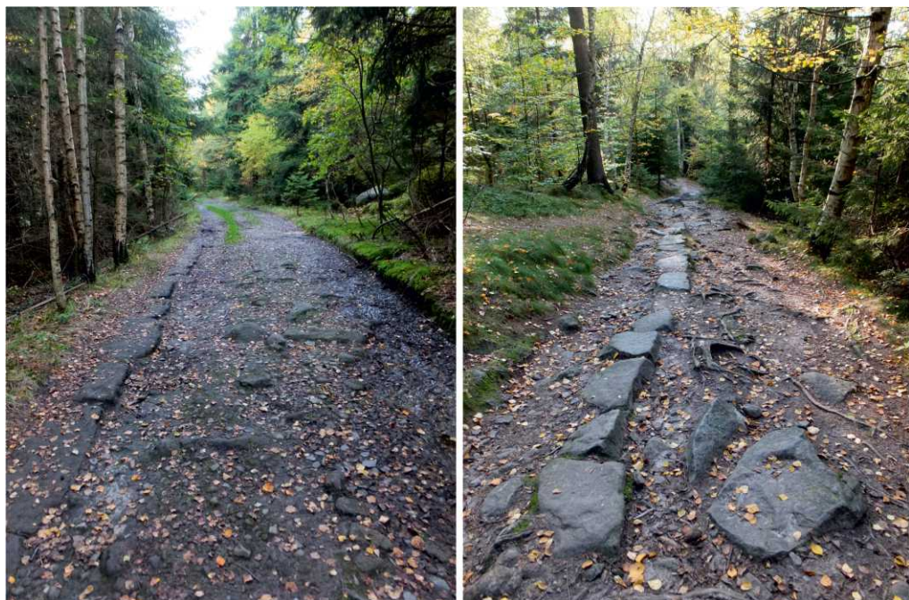
il.1.10. Przy niektórych starych drogach można dostrzec krawężniki.
