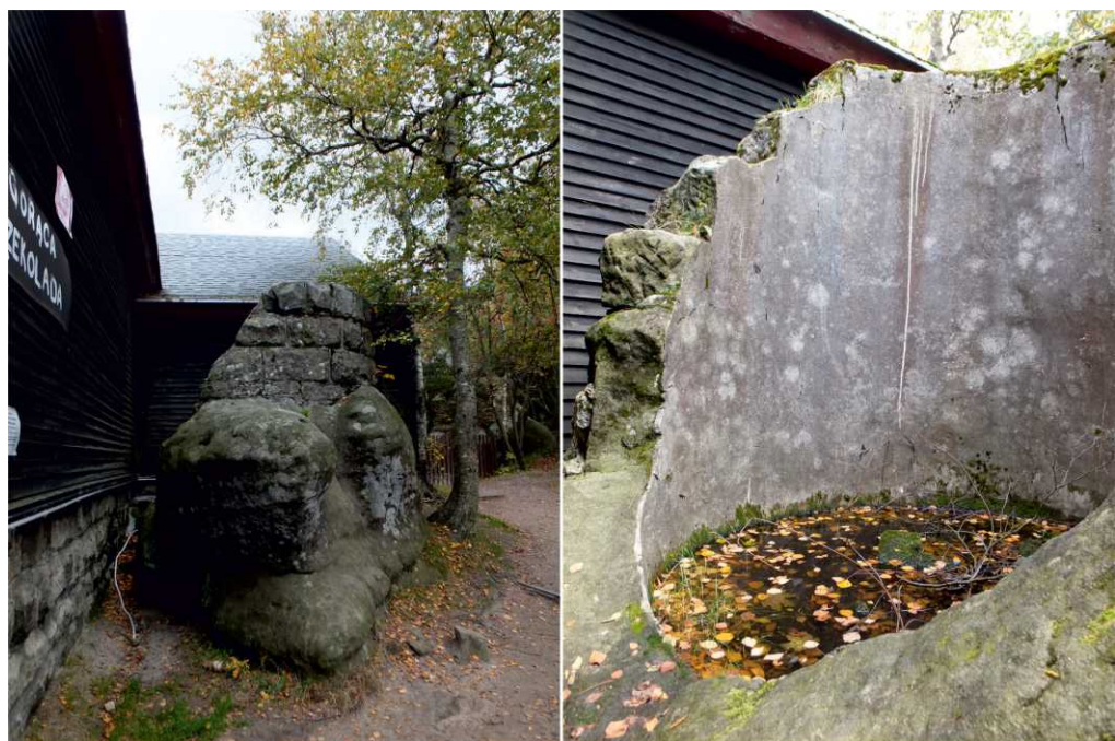
il.13.15. Kamienna cysterna na wodę obok schroniska na Szczelińcu Wielkim.
