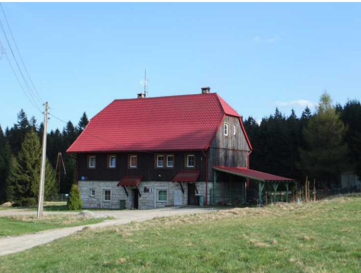
il.8.11. Wyremontowany budynek dawnego młyna w Karlowitz, obecnie w zarządzie PNGS.
