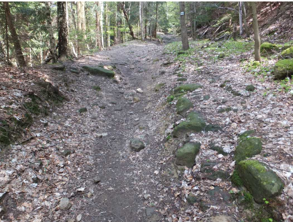
il.1.9. Bruk zniszczony przez erozję – z prawej strony widoczny fragment dawnej powierzchni drogi utwardzonej kamieniami (Pasterka – Ostra Góra).
