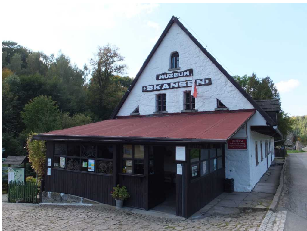
il.3.24. Skansen w Pstrąężnej. Dawny budynek mieszkalno-gospodarczy z kuźnią i sklepem z 1865 r.
