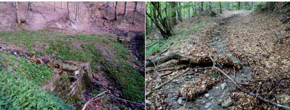
il.6.7. Zatkane przepusty na nieużytkowanych drogach przyczyniają się do niszczenia ich powierzchni – woda zamiast płynąć kanałem pod drogą, rozcina ją w poprzek lub wzdłuż; Darnków/Kociotek.
