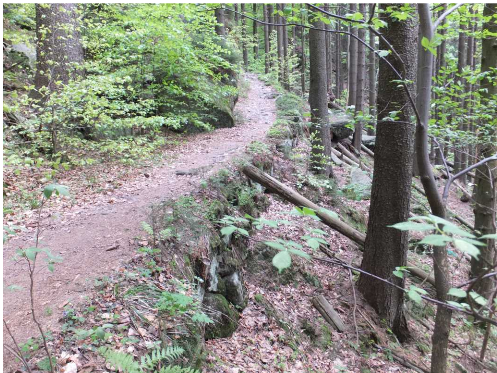
il.1.17. Budowa ścieżek turystycznych wymagała w niektórych miejscach konstrukcji specjalnych umocnień skarp lub kamiennych grobli; Pusta Ścieżka powyżej Wodospadów Pośny.
