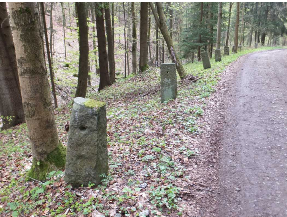
il.1.18. Kamienne słupki stanowią pozostałość po dawnym zabezpieczeniu drogi – przez otwory przewieszony był łańcuch lub montowane były barierki; Darnków.
