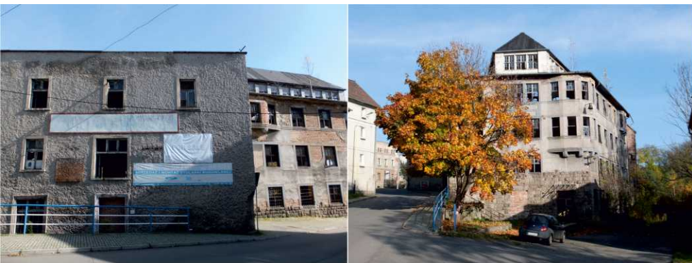
il.8.8. Opustoszałe budynki po dawnych zakładach dziewiarskich w Radkowie.
