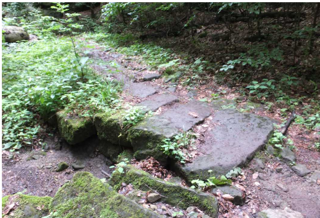
il.6.8. Najprostsze konstrukcje mostów tworzone były z płaskich, piaskowcowych płyt ułożonych obok siebie nad korytem potoku; Pusta Ścieżka.
