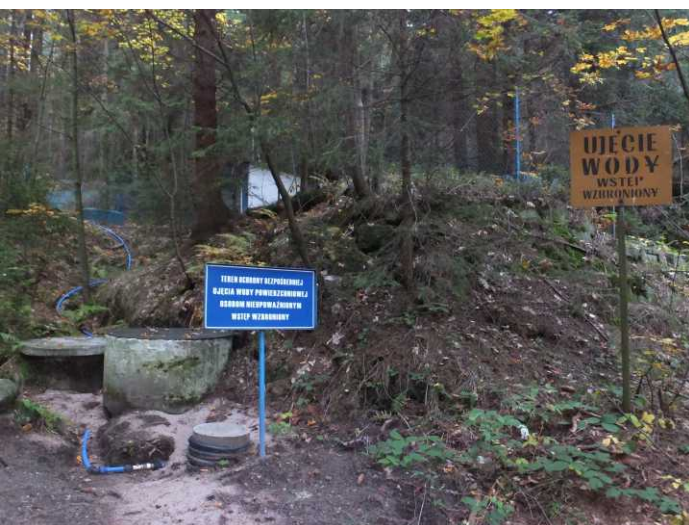
il.6.23. Ujęcie wody dla Kartowa u południowego podnóża Szczelińca Małego – funkcjonuje od XIX w. do dziś.
