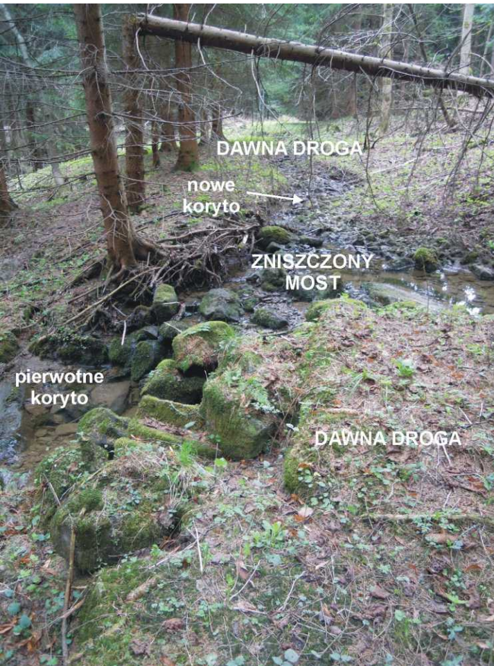
il.6.9. Zawalony most na nieużytkowanej drodze działa jak przeszkoda dla płynącej wody, co może doprowadzić do erozyjnego rozcięcia powierzchni drogi; Januszów.
