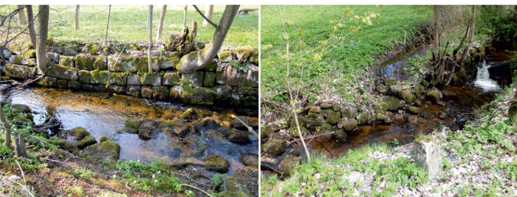
il.6.2. Korzenie drzew i erozja wodna przyczyniają się do niszczenia umocnień brzegów; Ostra Góra.
